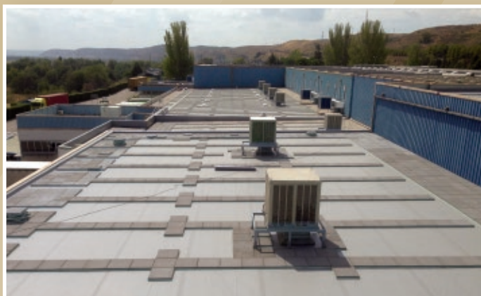
Rehabilitada Rhenofol CG con pasillos de Losa ITM
