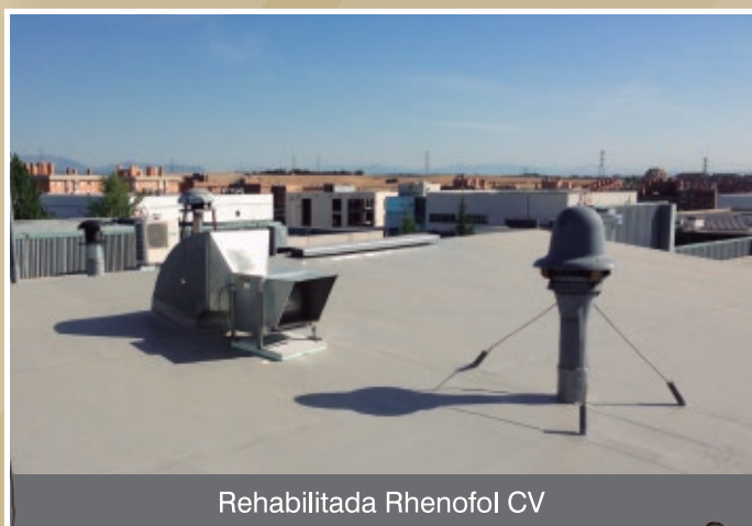
Rehabilitada Rhenofol CG con pasillos de Losa ITM
