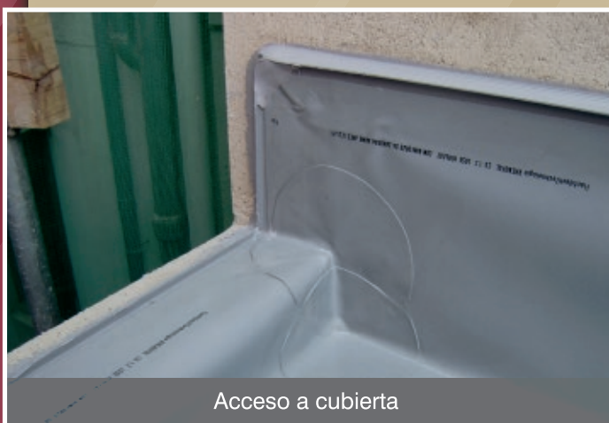
Colocación de la impermeabilización
